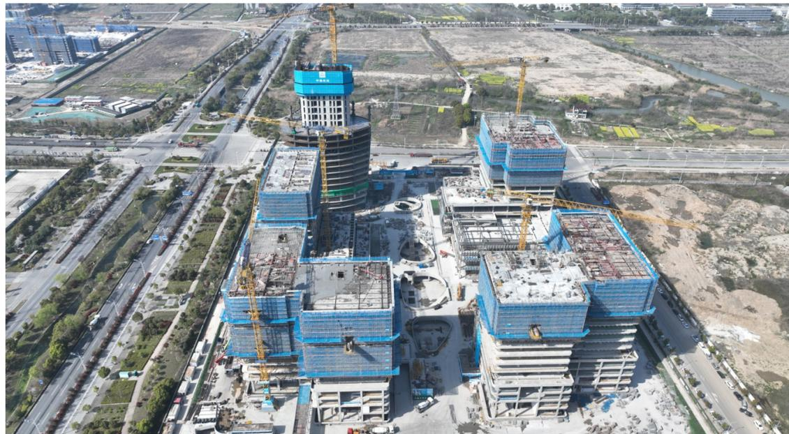
筑高度达到199.75米,建成后将成为嘉善唯一的超高层建筑。目前,1#楼大型金融机构施工至21层,2#楼国际金融中心南塔施工至12层,3#楼商务酒店和4#楼商务办公施工至14层。
